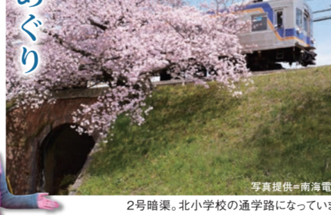
2号暗渠。北小学校の通学路になっています
