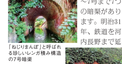
長した際に、線路の下に道路や水路を通してほしいという地域の人々の要望で造られました。この短い距離に7つの暗渠があり、今も現役と
