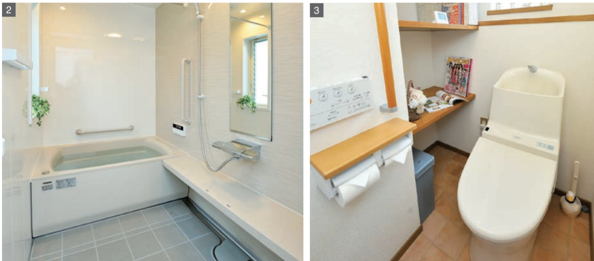
1 多彩な機能とお洒落なスタイルを誇るクリップの洗面台。幅広で横に2人並んで使える「片寄カウンター」や、背の低いお子様が立ったも顔が映る「チャイルドミラー」が人気。2 どんなサイズの浴室にもジャストフィットするタカラスタンダードのシステムバス。浴室を丸ごと断熱材で包み込む構造なので光熱費もお得。ゆるやかな丸みが体にフィットするラウンド型の浴槽は最高級品質の「アクリル人造大理石」。3 前回事の読書室のようなトイレ。階下物入れのスペースを活用した幅広の棚は書棚やちょっとした机にもなりそう。便器は洗いやすい手洗いを備えたTOTO GG-800。
