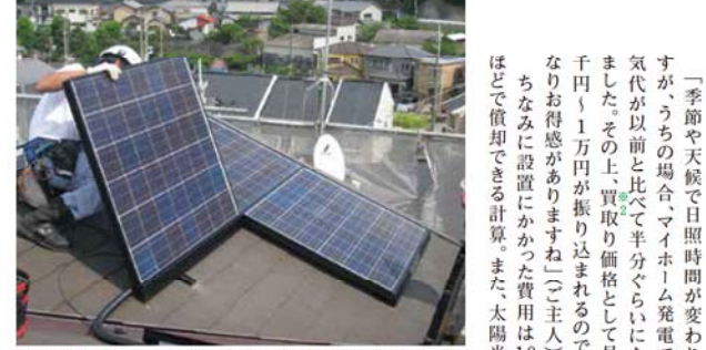
カラーベストに置き替えた屋根にモジュールを取り付け。設置は3~4日で完了します
