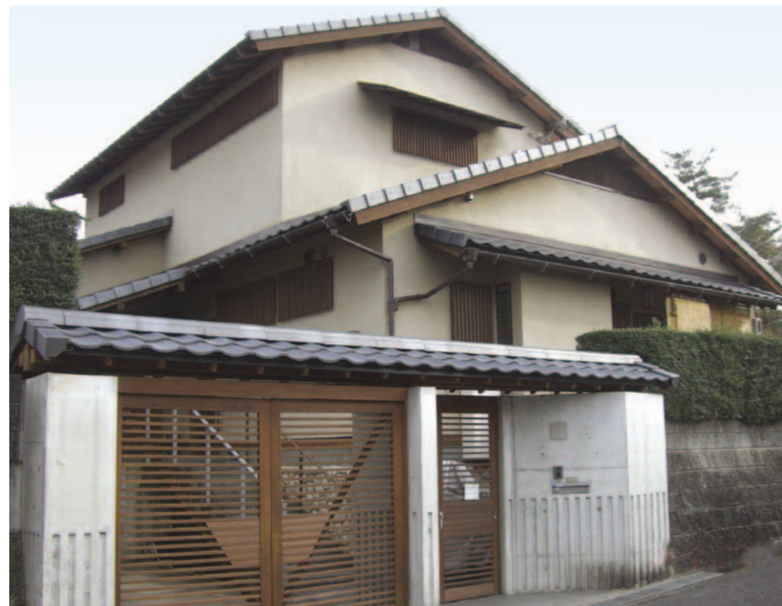
瓦の重みでたわんでいた門屋が水平に、ひきしまった正面玄関になりました。
