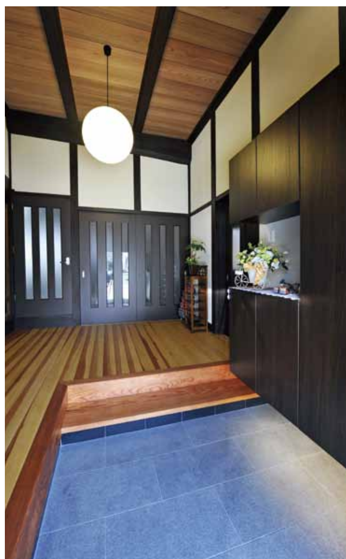
珪藻土やマツの緑甲板など自然素材をふんだんに使った玄関ホール。白い塗り壁と対比をなす黒い茶色の建具・枠材と下駄箱。それと和風ランプシェードがアクセントに
