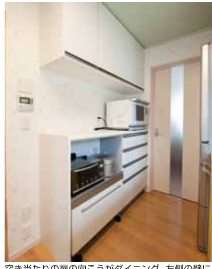
突き当たりの扉の向こうがダイニング。左側の壁に並ぶキャビネットの奥行きに合わせて、扉の位置を改修前から数10cm南側に移しました。
