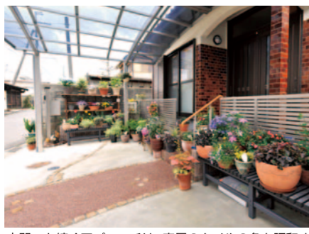
玄関へと続くアプローチは、家屋のタイルの色と調和するピンク系カラーのストーンパス仕上げ。天然の石を使っているため雨の日でも足元が滑りにくく安全。階段には将来に備えて手摺りも。
